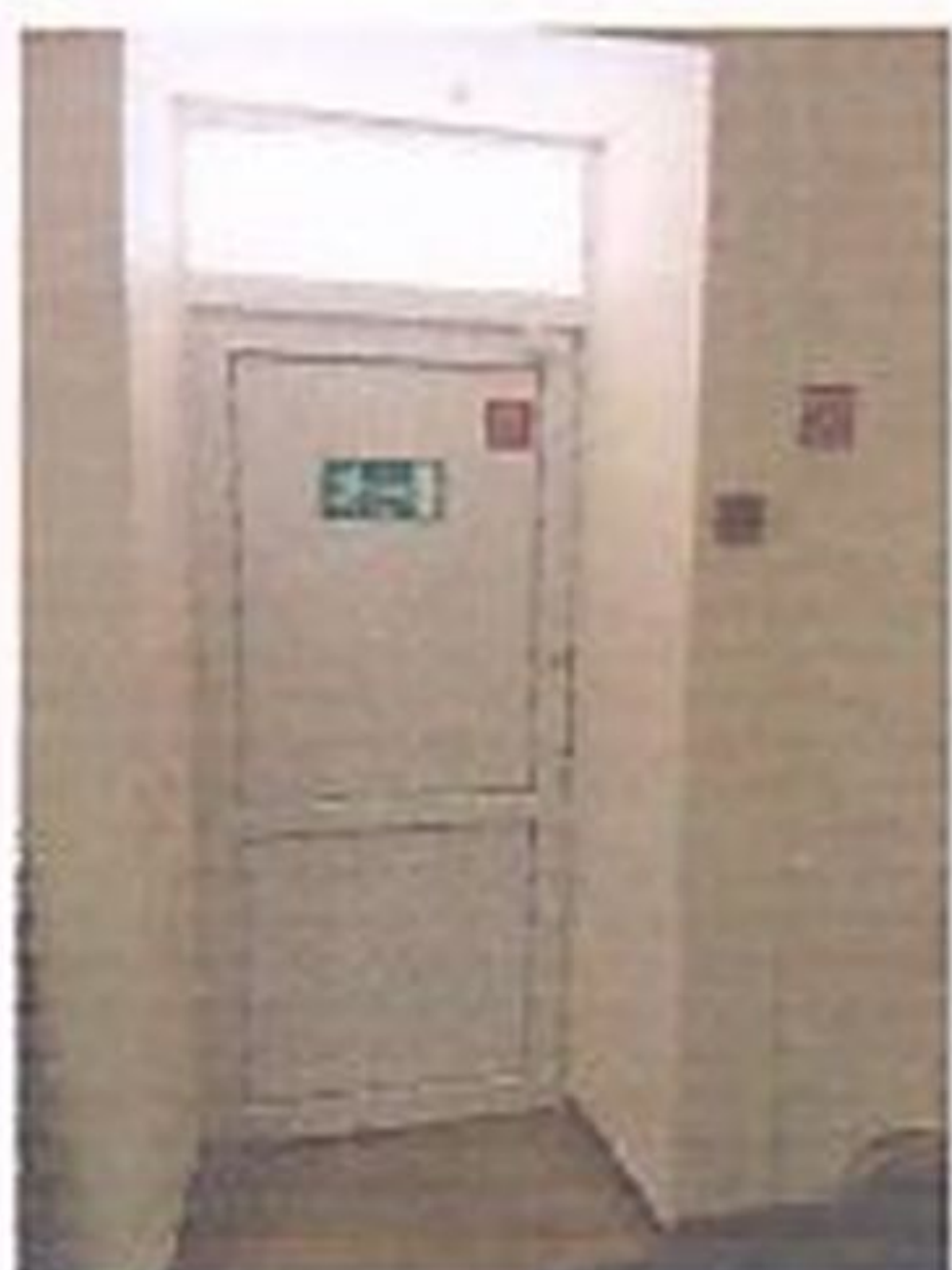
фото 36 - эвакуационный выход на балкон (2 этаж, левое крыло)
