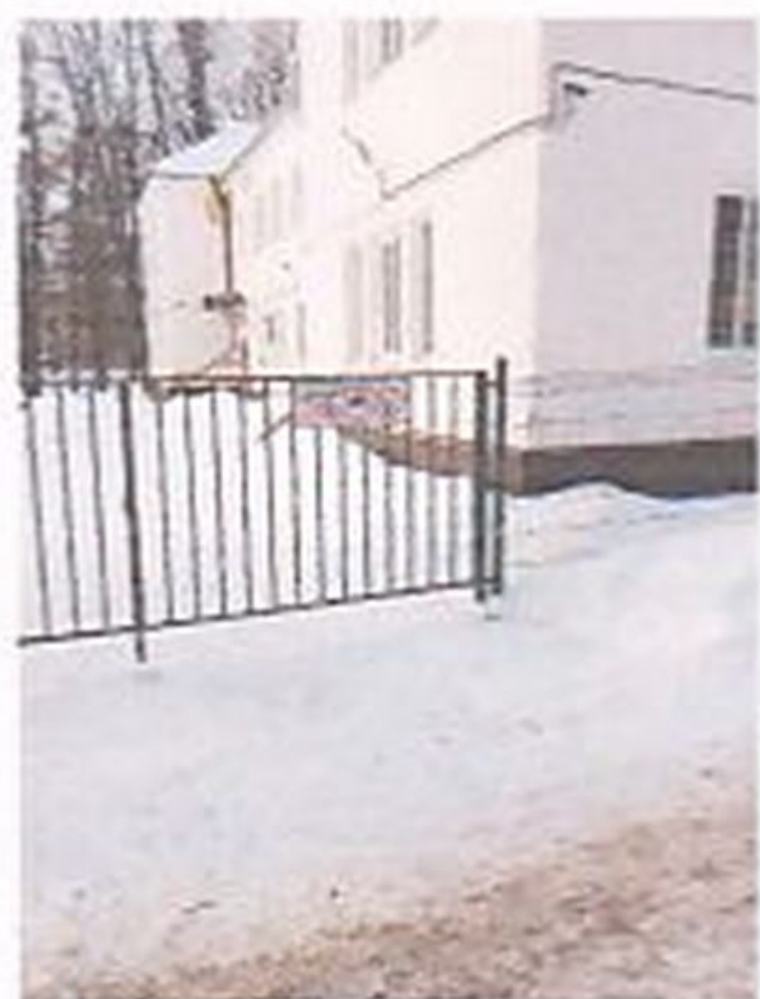
фото 6 - въездные ворота у правого крыла здания
