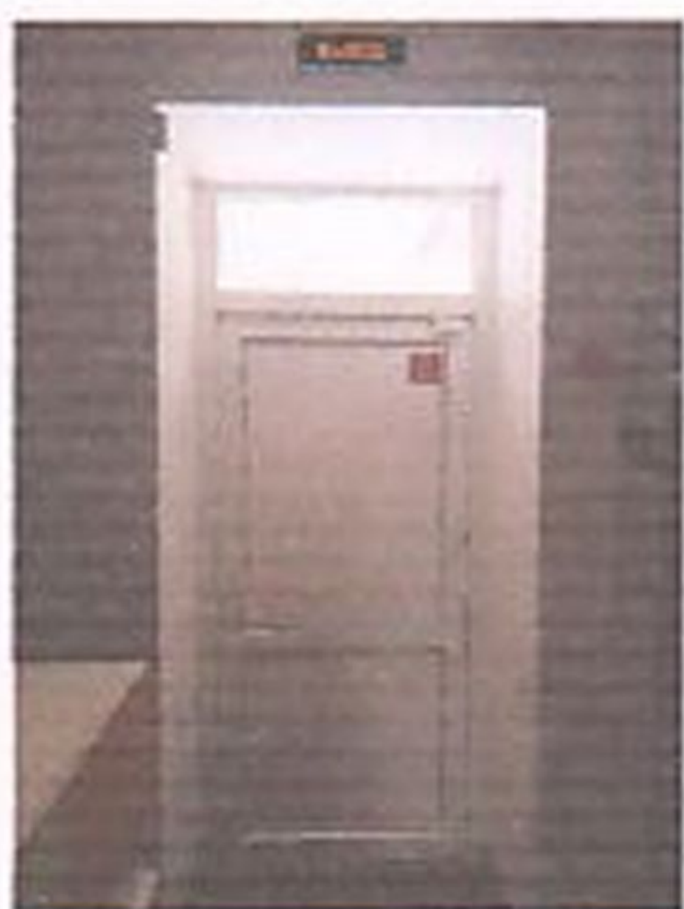
фото 35 - эвакуационный выход на балкон (2 этаж, правое крыло)
