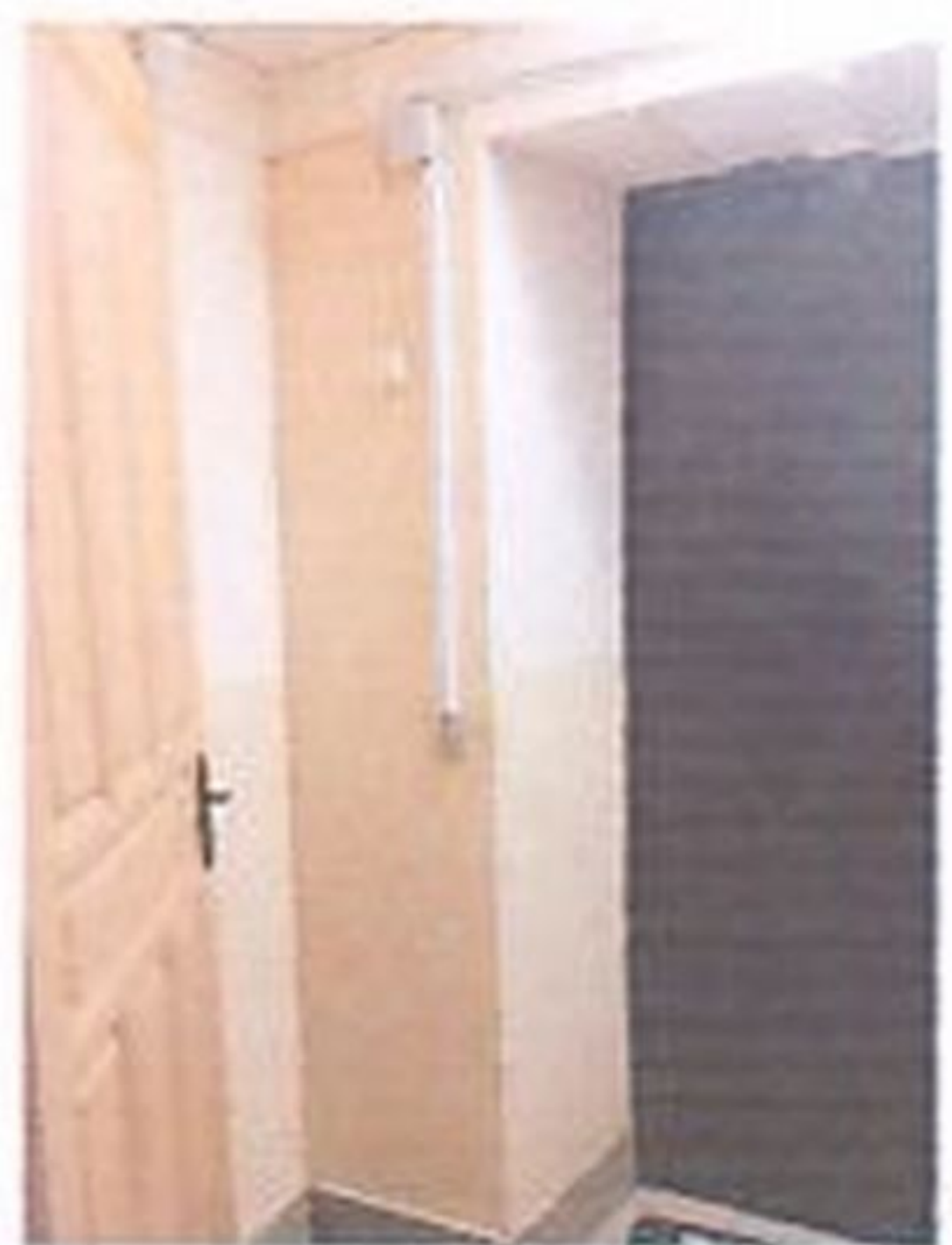
фото 8 - тамбур центрального входа, левое крыло
