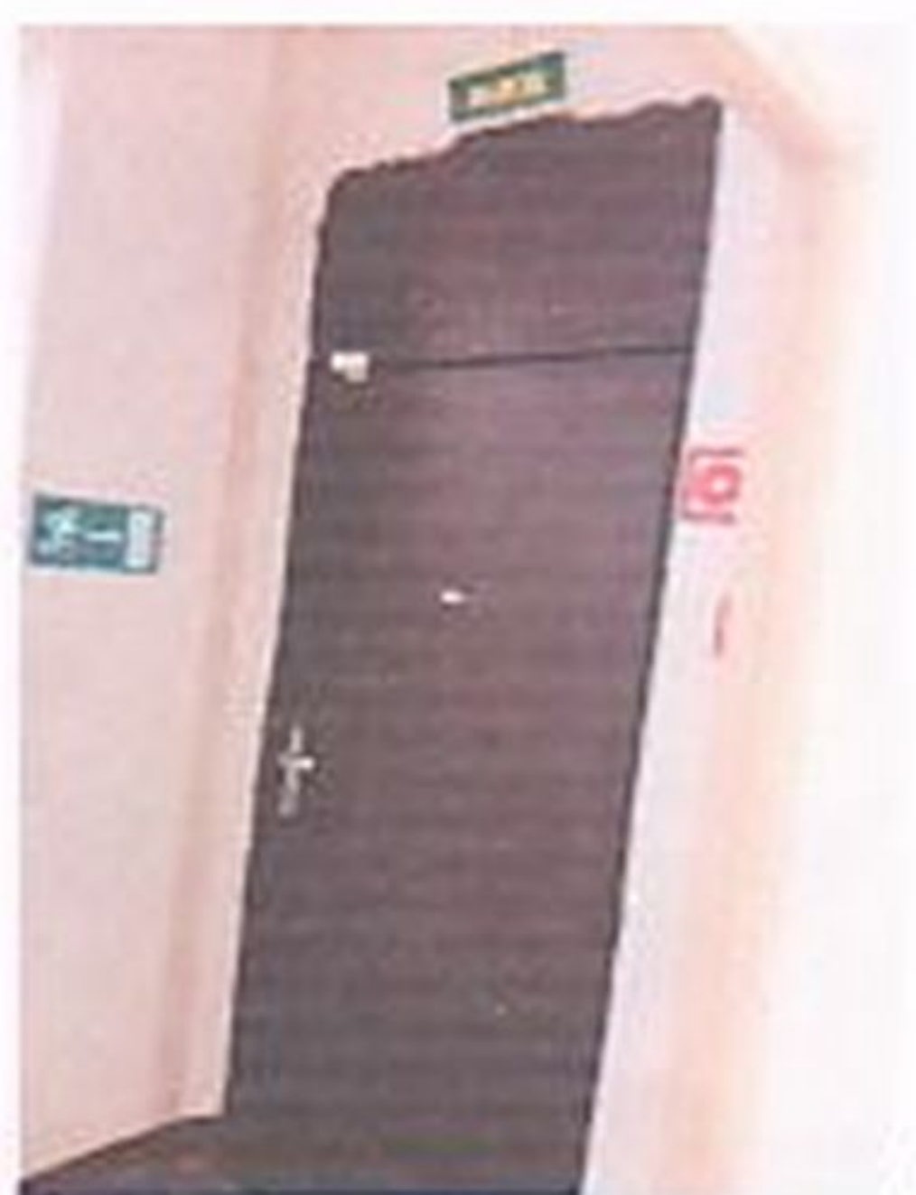
фото 34 - запасный выход (1 этаж, левое крыло)
