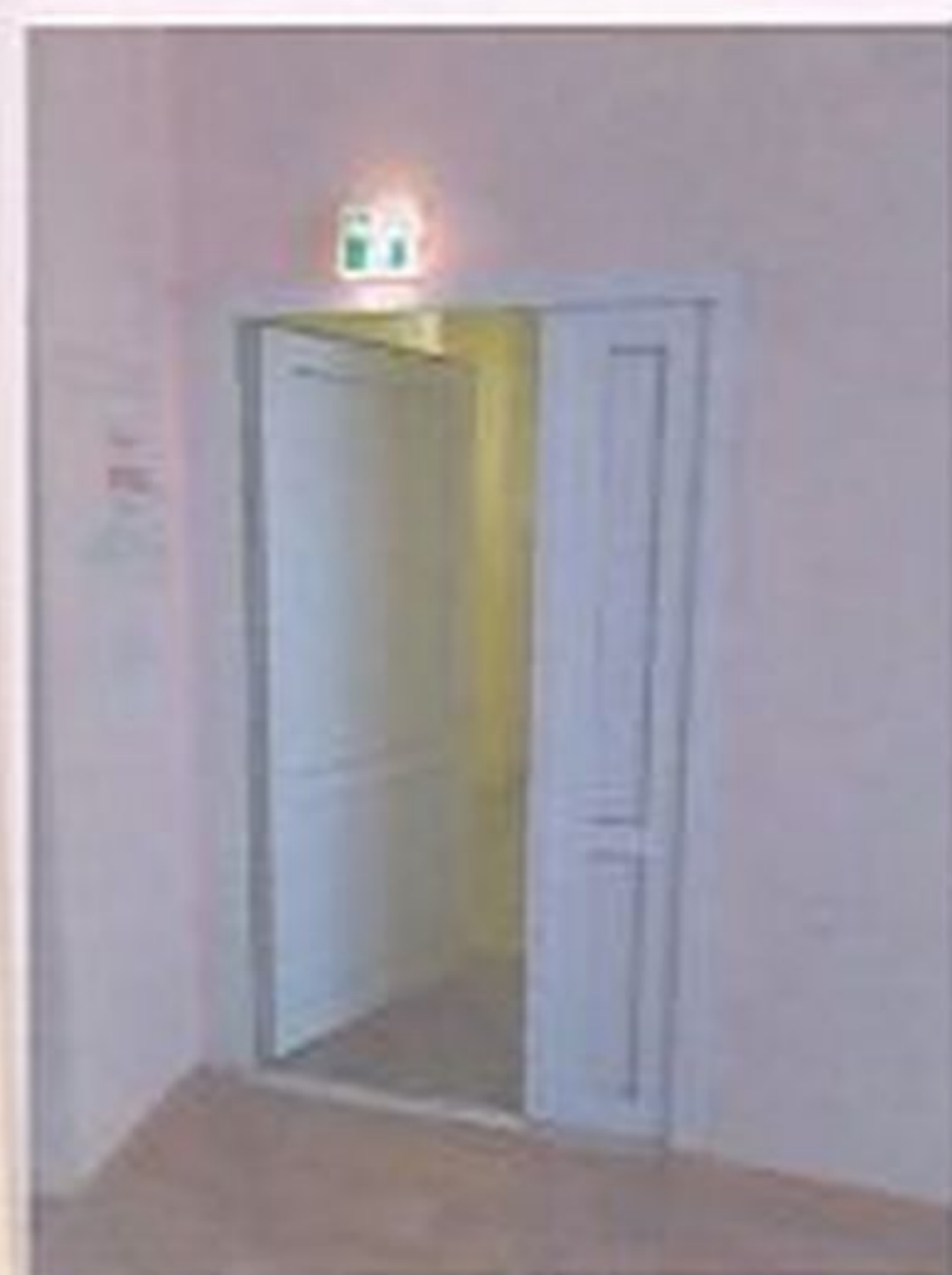
фото 5 – Наружная дверь выхода из помещения на лестницу.
